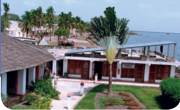
Panneaux solaires de l'hôtel Kadiandoumagne de Ziguinchor, bénéficiaire du programme de mise à niveau des entreprises et de la ligne « verte » SGBS.
