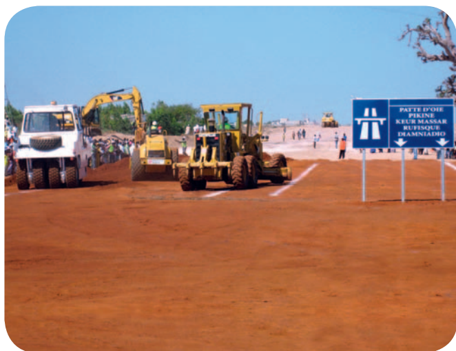
Démarrage des travaux de construction de l'autoroute à péage
